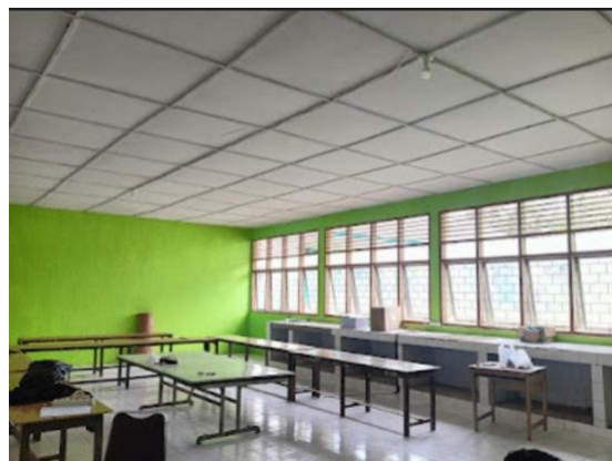
Gambar 1. Kondisi Ruang Sebelum Intervensi
